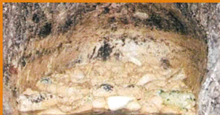
Zanesené potrubie a septik od oleja
